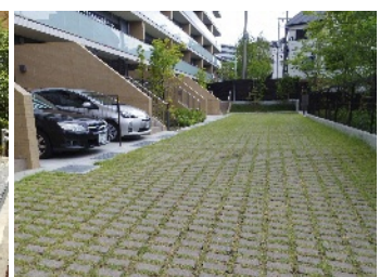
緑化舗装を用いて、駐車場を殺風景にしない配慮をしている。
