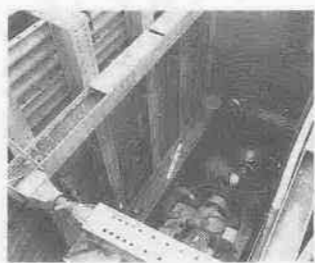
急ピッチで進む下水道工事
