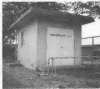
川越市災害用給水井戸(野田中学校内)
