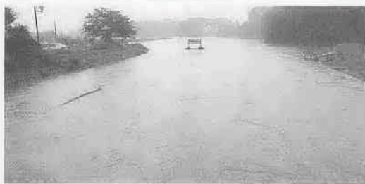
旭橋から下流方向・大雨で増水した新河岸川 (8月28日・下新河岸)
