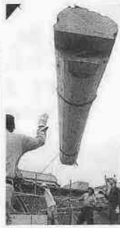
牛梁の交換作業
