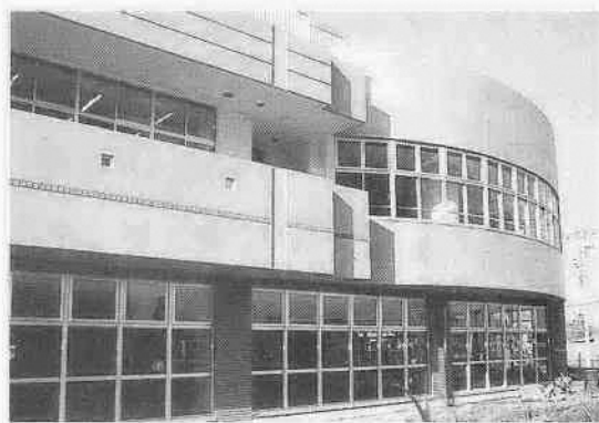
建設が進む複合施設（伊勢原町5丁目）
