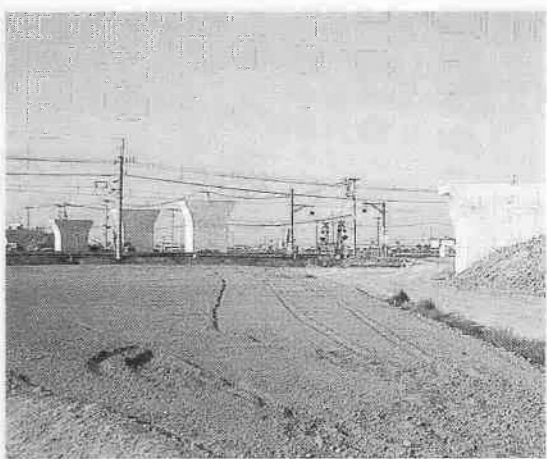
扇橋上流に建設中の寺尾大仙波線（砂）
