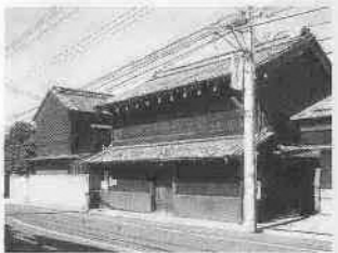
③綾部家 喜多町四一九 明治時代初期建築
