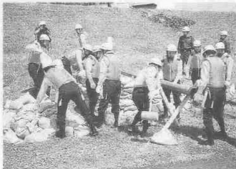
水防工法の1つ、「月の輪」に取り組む水防団員
