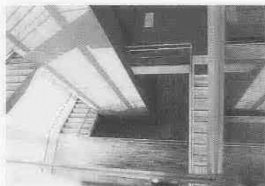
上から見た階段とエレベーター
