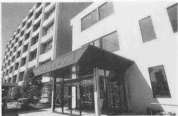
建設中の市役所東庁舎 (2月27日撮影)
