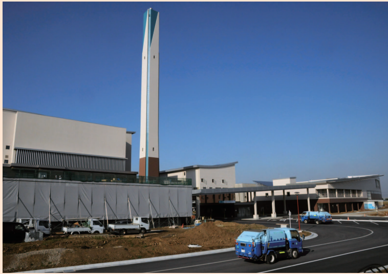
熱回収施設の試運転が始まった資源化センター
