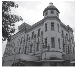
③埼玉りそな銀行川越支店(大正7年) 当時最先端だった鉄骨鉄筋コンクリート造を導入した、川越近代建築の草分け的存在。
