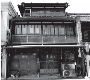
⑧小川菊(大正13~14年) 木造3階建て。上階は屋根と外壁が後退する。純和風だが、レンガの袖壁が大正風。
