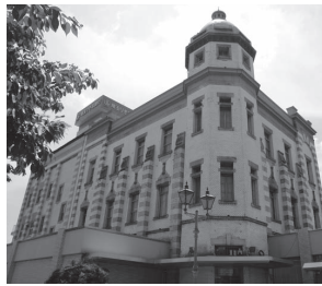
③埼玉りそな銀行川越支店(大正7年) 当時最先端だった鉄骨鉄筋コンクリート造を導入した、川越近代建築の草分け的存在。
