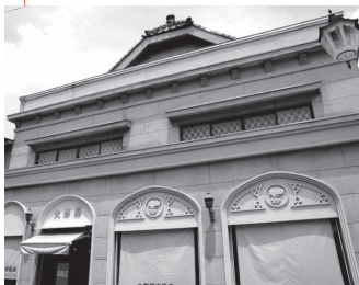
⑫大野屋洋品店(昭和5年) 和瓦葺きの半切妻屋根に洋風の棟飾りをのせた独特の屋根形状が特徴。
