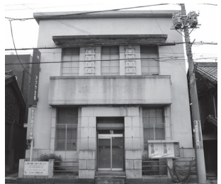
⑨川越商工会議所別館(昭和2年) 旧帝国ホテルを設計したF・L・ライトの作風の影響をいち早く取り入れた建物。
