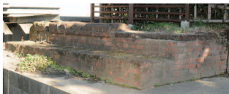
レンガ製の橋脚の一部が残っています
