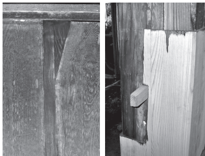
柱は根継ぎをして元の柱を生かしながら強度を高め(写真右)、床板は腐朽した部分だけを削り新しい材木と組み合わせられています(写真左)。
