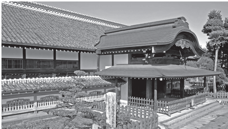
優美な曲線を描く唐破風と櫛型塀は、本丸御殿の魅力の1つ。20,000枚以上ある瓦の7割を再利用。新しい瓦は西側に配置しました。
