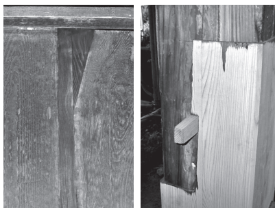
柱は根継ぎをして元の柱を生かしながら強度を高め(写真右)、床板は腐朽した部分だけを削り新しい材木と組み合わせられています(写真左)。
