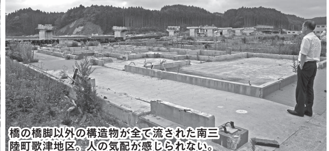
橋の橋脚以外の構造物が全て流された南三陸町歌津地区。人の気配が感じられない。
