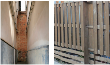
蔵の間のレンガ塀 大和張りの板塀(民家) (蔵造り資料館・幸町)
