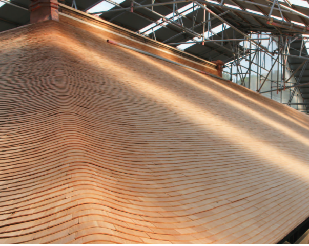
葺替え作業を終えたばかりの柿葺屋根
