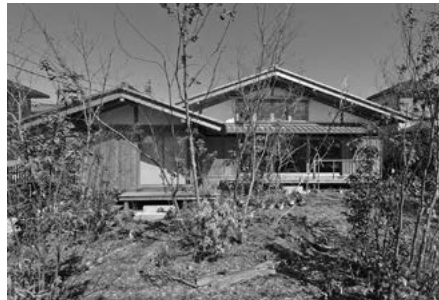
雑木の庭に建つ石場建ての家
