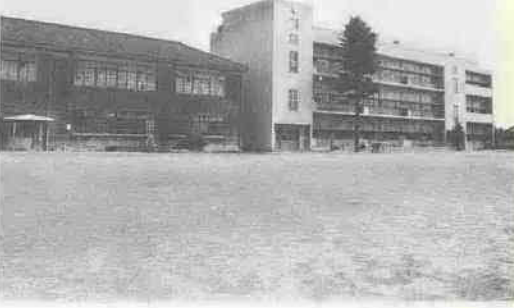
増改築される仙波小学校
