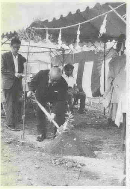
〈起工のくわ入れをする加藤市長〉
