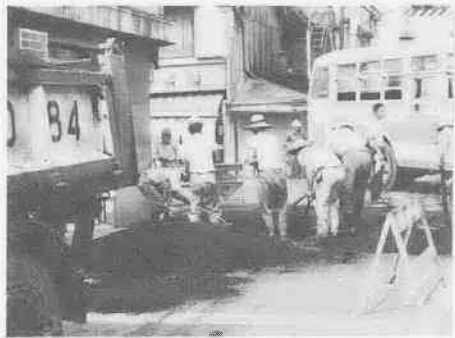
着々と道路舗装
