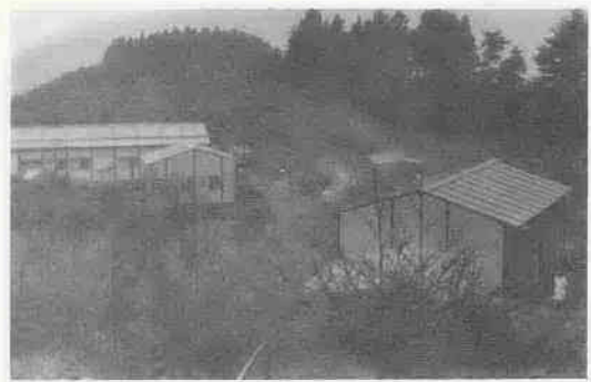
川越市山の家(仮設)
