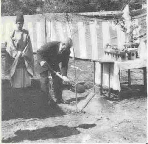
改築される菅原町保育園のくわ入れをする加藤市長
