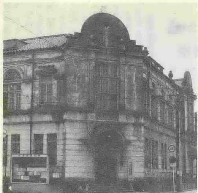
建築後60年を経過し老朽化した市庁舎
