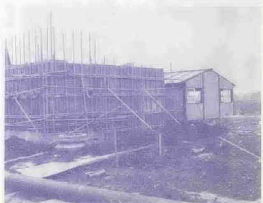
〔浄水場建設の用地〕
