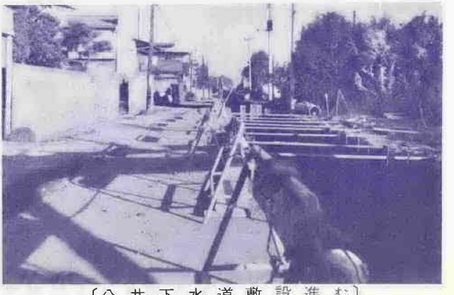
〔公共下水道敷設進む〕
