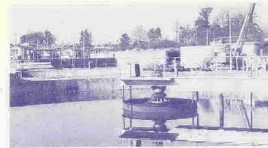
設備が進む滝ノ下処理場
