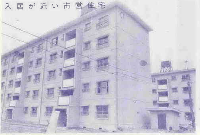
市営住宅が近い
