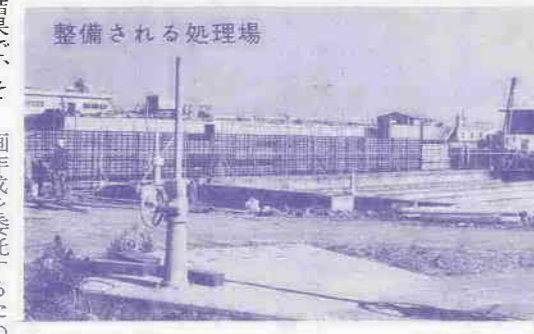
整備される処理場
