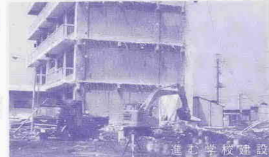
進捗 学校建設
