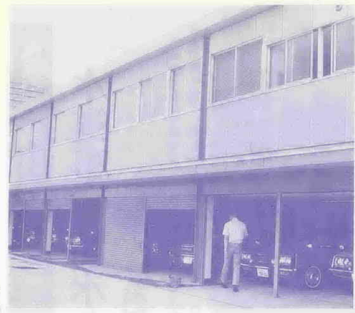
完成した庁舎車庫棟
