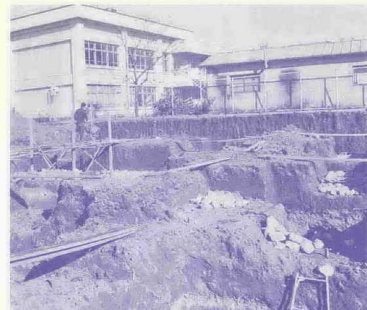
着工された霞ヶ関北公民館
