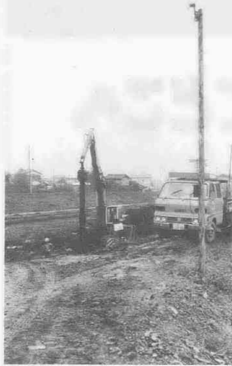
雨の中も続けられる掘削作業(11/2撮影)
