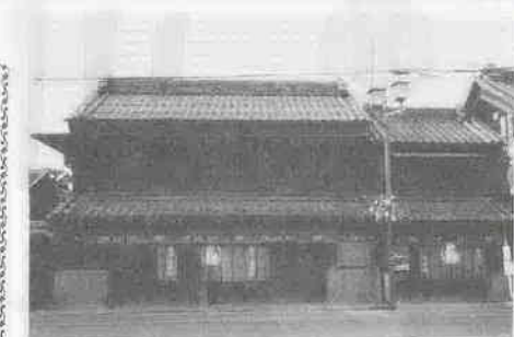
⑪旧小山家住宅 幸町7-9 明26・4・19 〈蔵造り資料館〉 所有者…川越市
