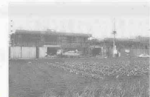
仮称高階南公民館
