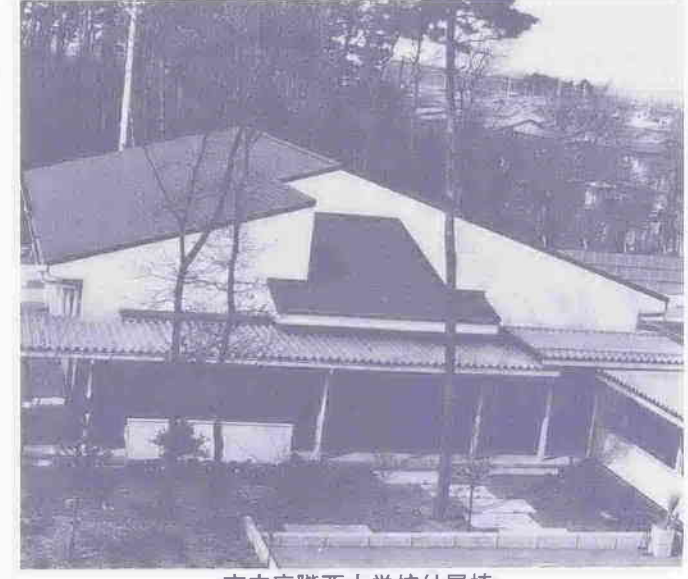
市立高階西中学校付属棟
