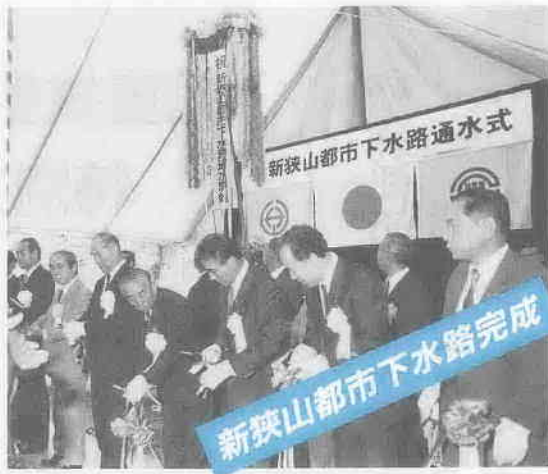
新狭山都市下水道通水式 この都市下水道は、川越・狭山工業団地に降った雨により周辺地
