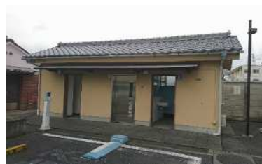
幸町公衆トイレ
