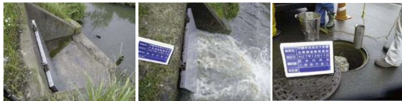
雨水吐口（晴天時） 雨水吐口（雨天時） 雨天時の水質モニタリング状況
