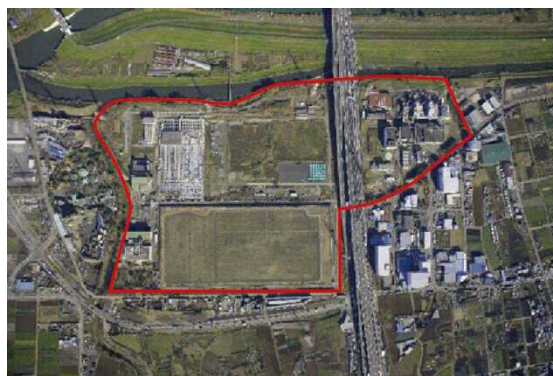
新河岸川水循環センター
