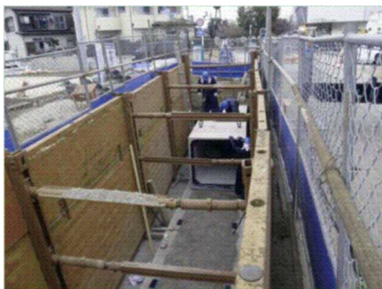
雨水管きよの整備
