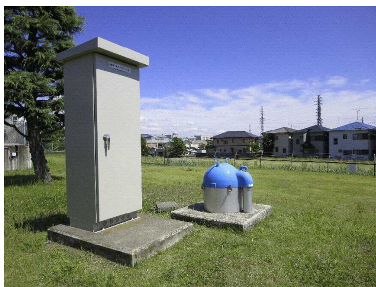
郭町浄水場第1水源
