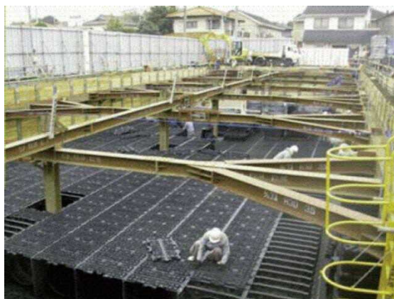
雨水貯留施設の整備
