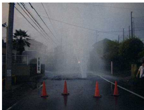
2008年8月の漏水状況
