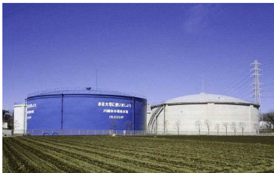
中福受水場配水池
