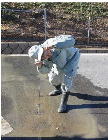
音聴棒を使った漏水調査
