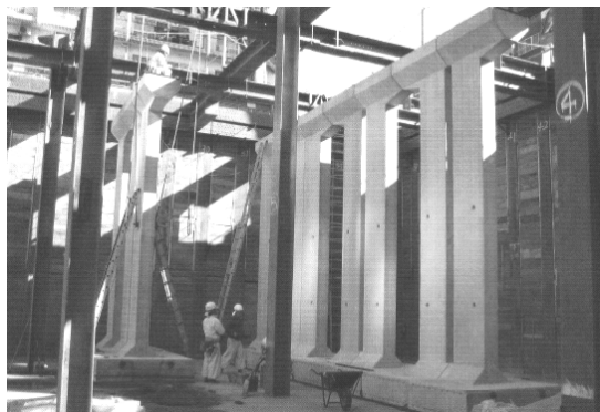
南大塚駅南口の雨水貯留施設
