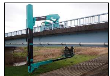
図 3.1 定期点検状況
