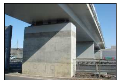
図 3.2 橋脚の耐震補強状況 (鉄筋コンクリート巻立て)
