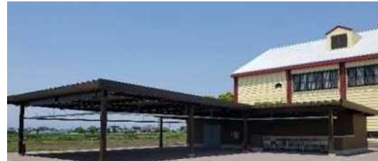
大屋根広場(バーベキュー場)
