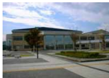
川越運動公園(総合体育館)
