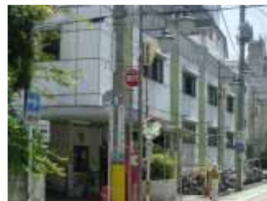
川越駅東口自転車駐車場
