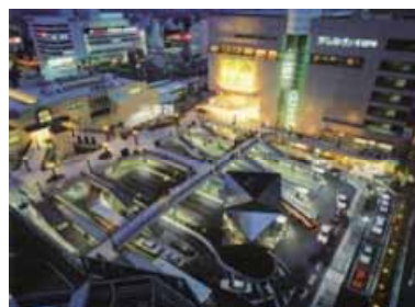
川越駅東口公共地下駐車場
