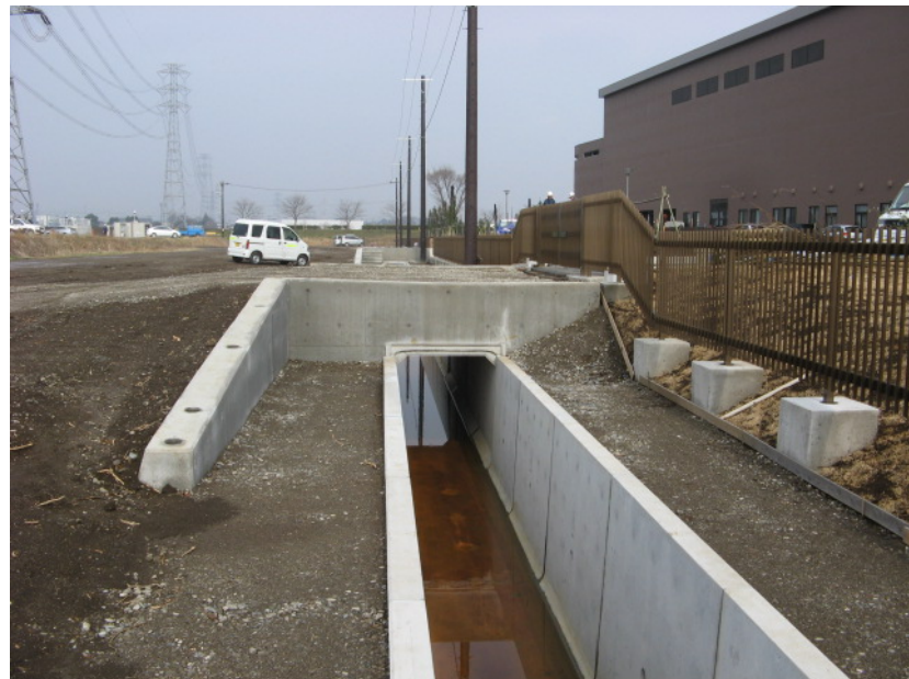
④資源化センター通路 側面
