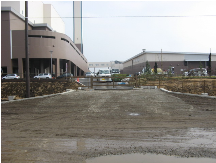
③資源化センター通路 正面
