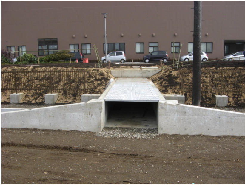
①高温水配管路 正面
