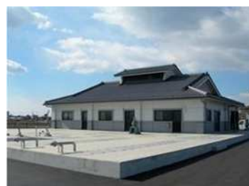
鴨田農業集落排水処理施設
