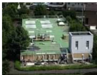
久保川水質浄化施設
