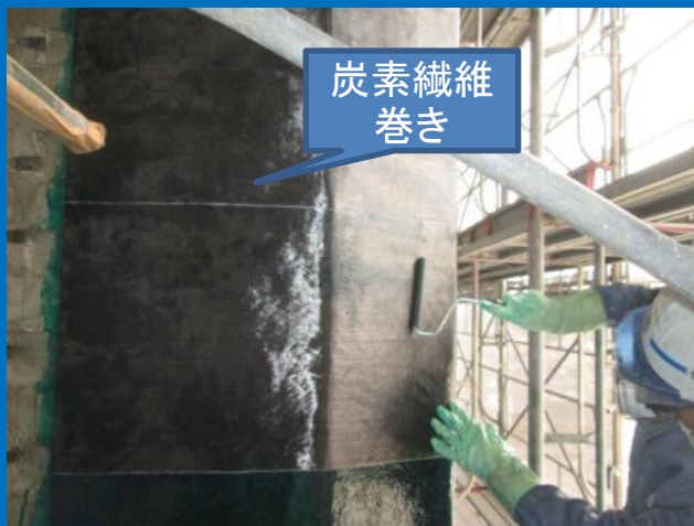
◀北面▶炭素繊維巻作業状況
