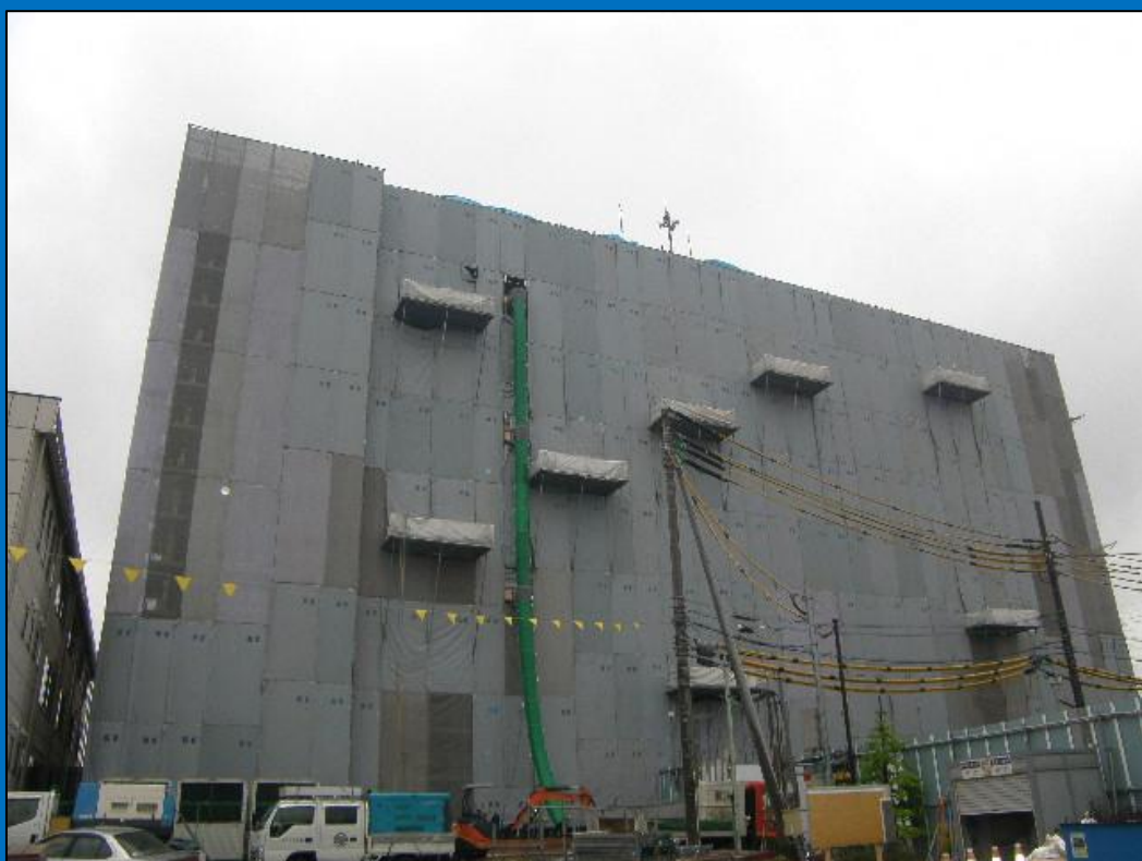
《北面》 外部足場設置状況
