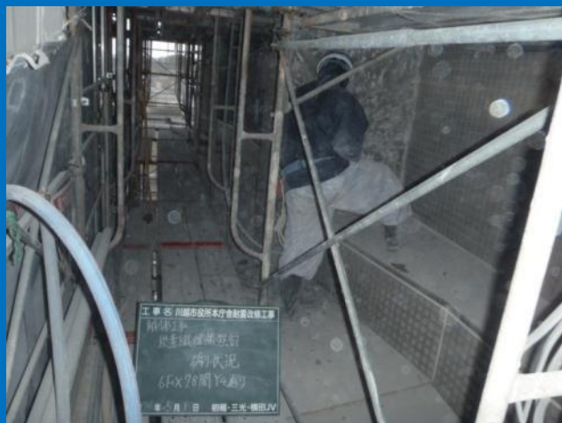
◀北面▶タイル撤去状況
