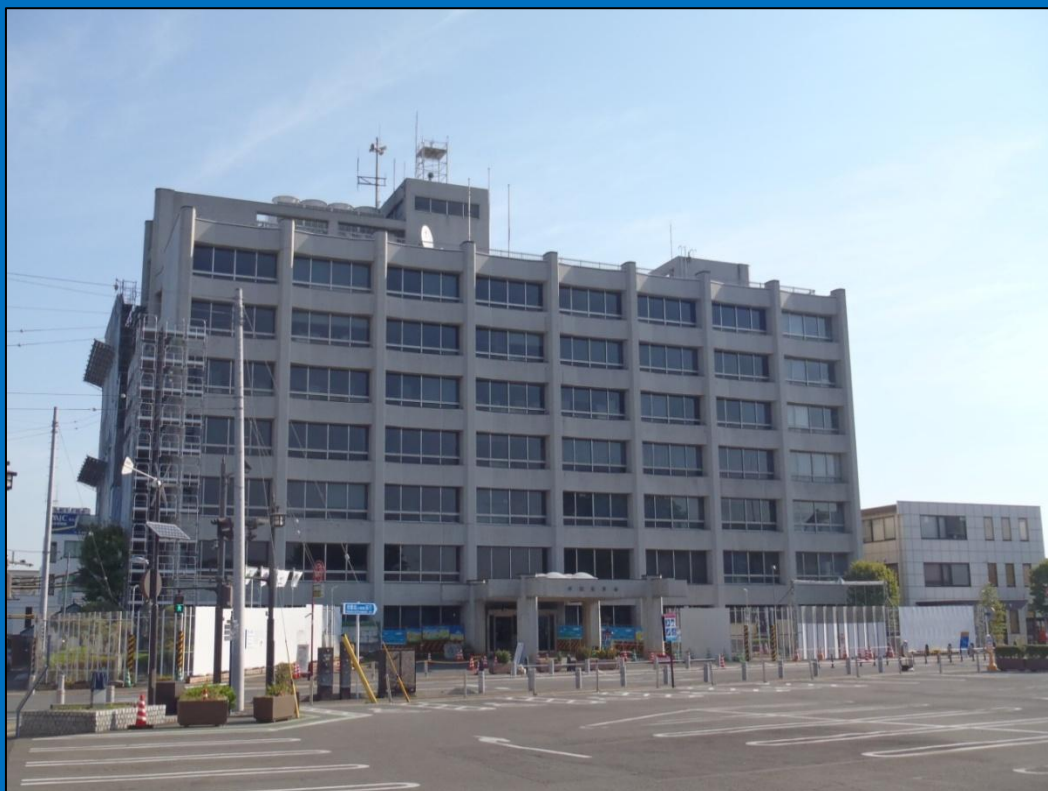
《南面》 仮囲い設置状況
