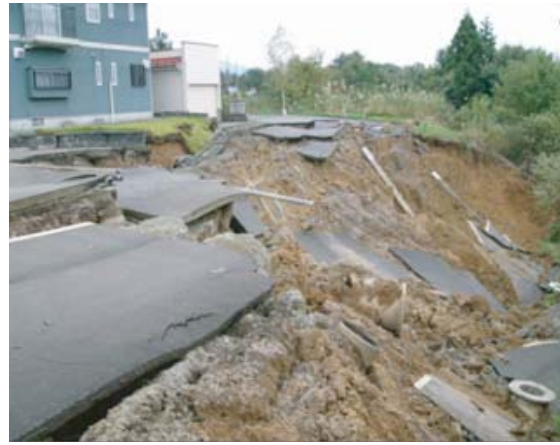
盛土造成地の変動に伴う被害(写真:長岡市) わが家の宅地安全マニュアル(国土交通省)より
