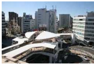
②川越駅西口駅前広場改修事業
