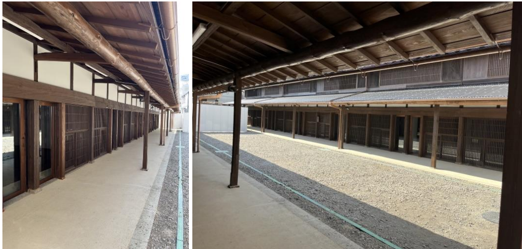
旧川越織物市場東棟・西棟の完成写真
